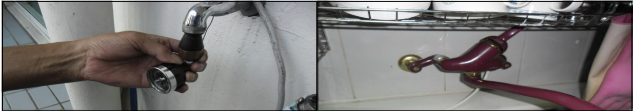
저소득층 옥내급수관 개량사업(옥내급수관 개량)
